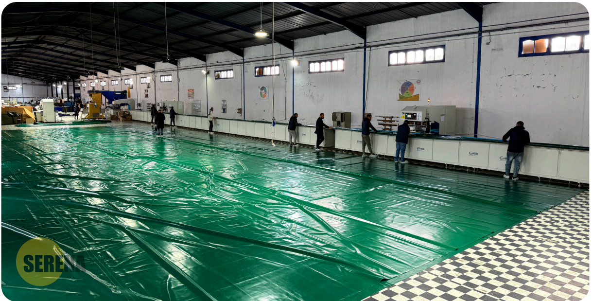
Fabricación de un tanque de 1000 m 3
